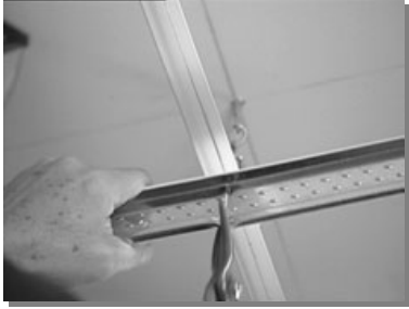
Instale las "T" secundarias del borde
