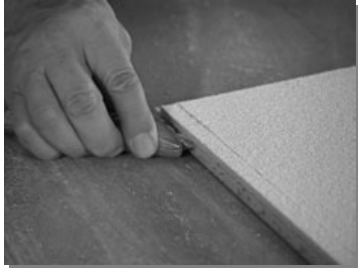
Los plafones de los bordes de orilla tegular pueden requerir cortes de campo. Córtelos con la cara hacia arriba
