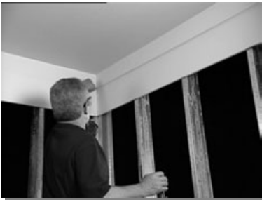
Marque la altura deseada para el nuevo techo
