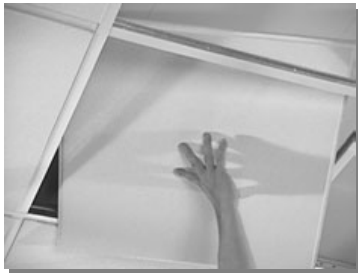
Incline los plafones – encima del marco y bájelos a su lugar
