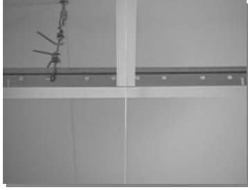
Alinee la segunda cuerda guía con la primera "T" secundaria de cuatro pies (1200 mm)
