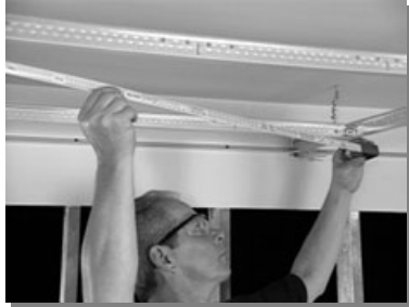
Escuadre la suspensión midiendo a través de la diagonal de la apertura de ésta
