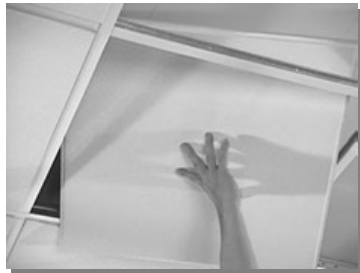
Incline as placas – por sobre o perfil e abaixe-os em seu lugar
