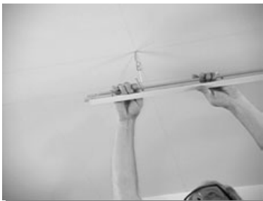
Instale primeiro o perfil T principal
