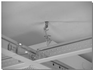
A suspensão pode requerer suspensores adicionais para suportar o peso dos artefatos de iluminação
