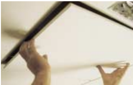
Dalle Vector démontée vers le bas sans aucun outil spécifique
